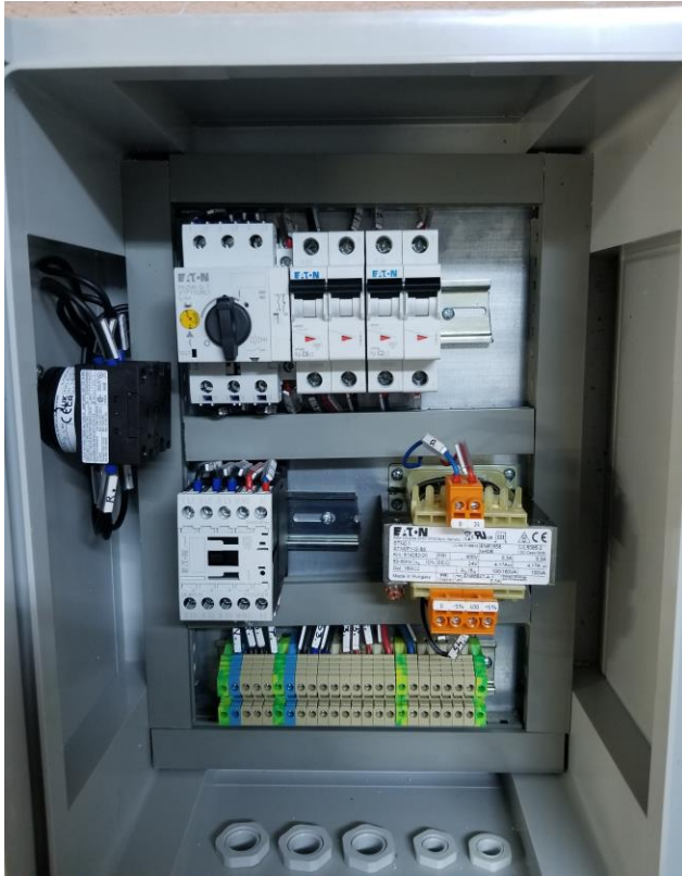
Fig. 2: Detalii execuție tablouri electrice ( stânga = tablou electric 4 kW; dreapta = tablou electric 9 kW)
